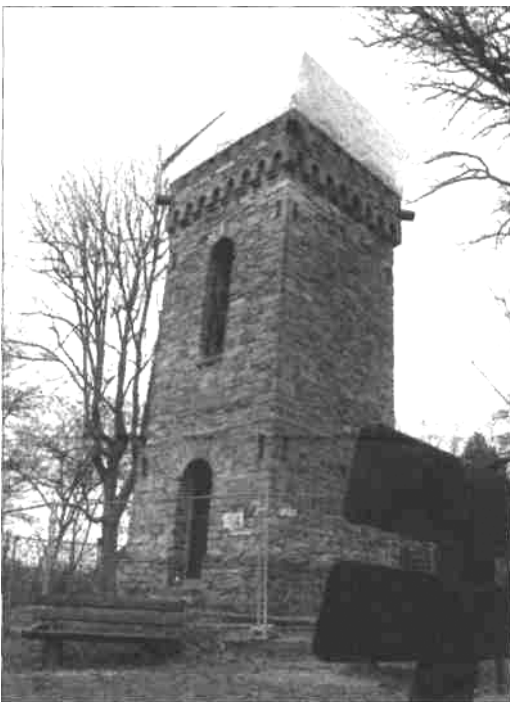
Abgesperrt: Der Turm auf dem Burgberg soll saniert werden.
